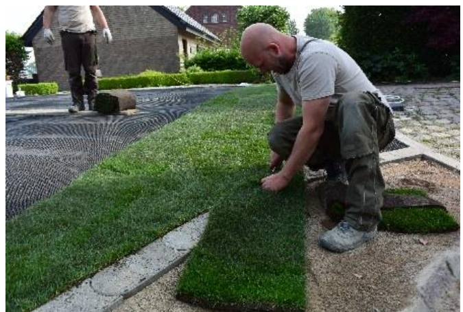
Verlegung von Rollrasen auf der TALPATEC Premium Maulwurfsperrbahn
